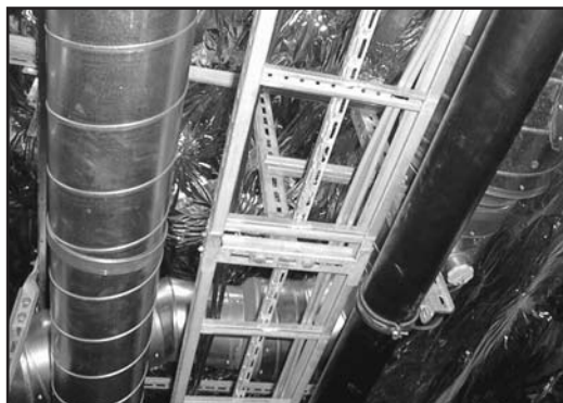
Fra boligkvarteret ombord på Oseberg Sør. Norsk Hydro.
